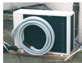
Achterzijde buiteneenheid met leiding en quick connector
